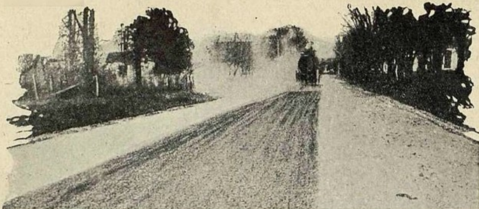
Разливка масла по пыльной дороге—грубая ошибка. Пятнистая полоса в середине показывает, что масло разлилось неравномерно и не пропитало поверхности, а лишь смешалось с пылью
